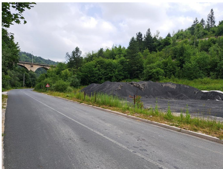
Slika 13: Deponija posipnog materijala sjeverno od izvorišta
